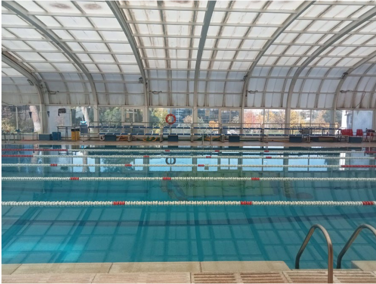
Imagen 2: Instalación de Piscina en Brains International School.
